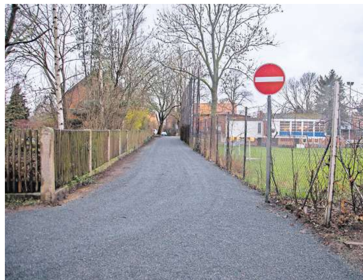
Die Zufahrt zum Parkplatz des Sportzentrums wurde mit Rollsplit abgedeckt: Das reicht dem Ortsrat nicht. FOTO: JULIA DITTRICH
